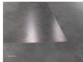
Padozatápolás 2. lépése: padló felületkezelése
